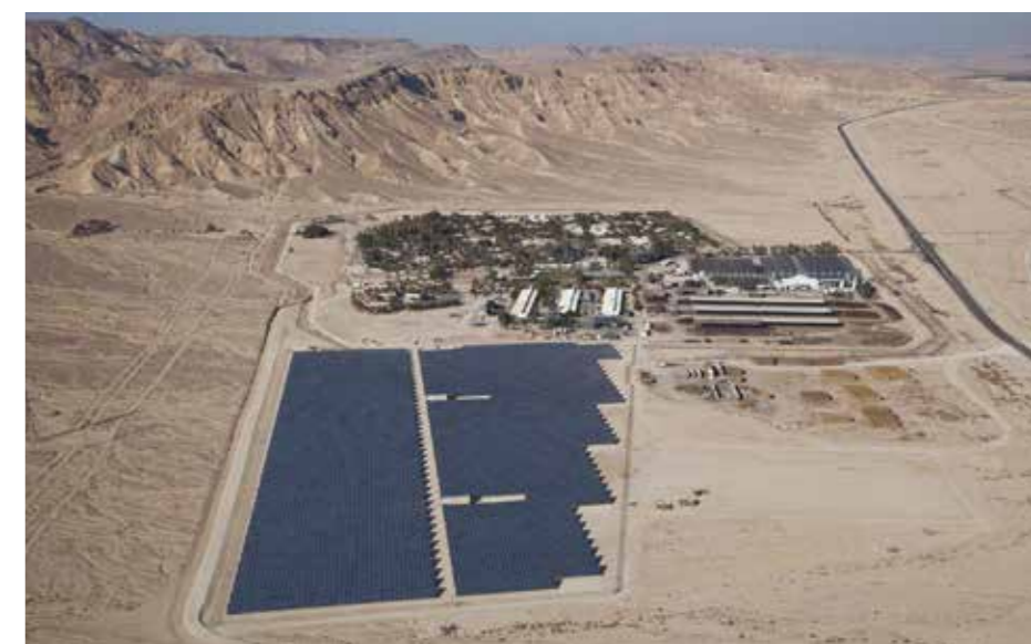
Solcellsparken vid kibbutzen Ketura i södra Israel byggdes i början av år 2011 och täcker drygt åtta hektar. Parken producerar cirka nio miljoner kilowattimmar el per år och förser stora delar av området med el. Foto: Arava Power Company
