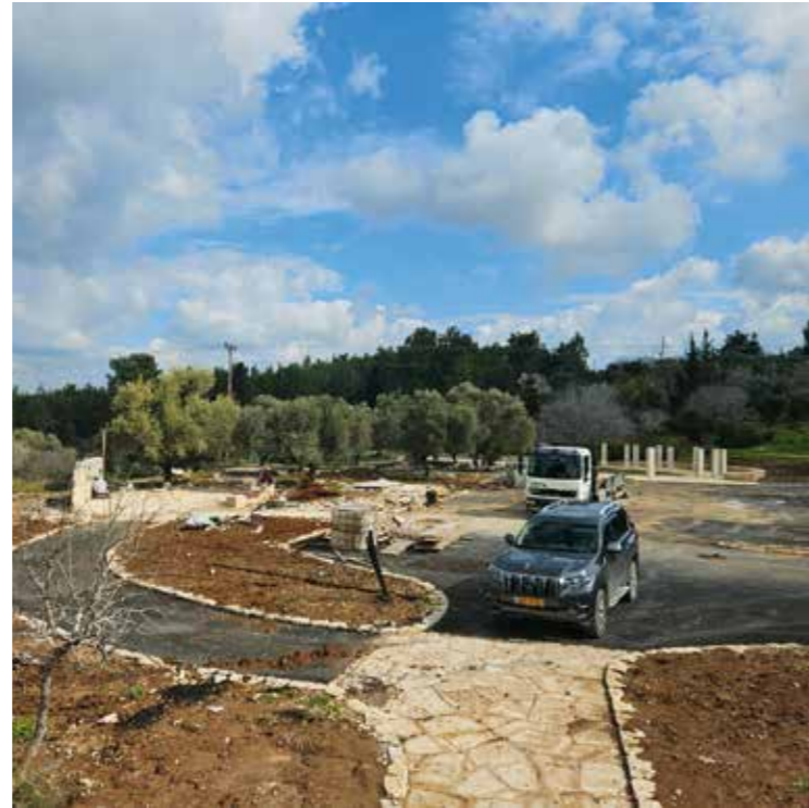
Foton: KKL-JNF Parkeringen åtgärdas och området handikappanpassas.
